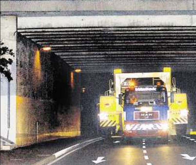
Die Unterführung unter der Autobahn 81 zwischen Untergruppenbach und Happenbach wurde vor einiger Zeit für Schwertransporte tiefer gelegt.
