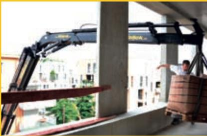
Die geringe Bauhöhe des Knickarms, das kurze Anhängen sowie die Überstreckbarkeit ermöglichen das Eindringen in und das Kranen im Gebäude.
