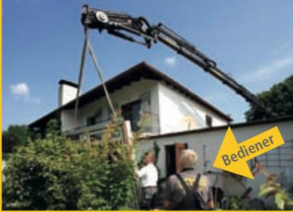
Der Bediener mit der Fernsteuerung direkt vor Ort kann präziser und schneller arbeiten und erspart damit Personal und Zeit bei gleichzeitig höherer Sicherheit.
